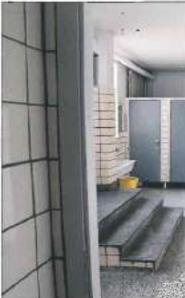
Skoletoiletter skal gå fra lugt til lyst. Her ses et eksempel på en opgraderet toilet i Vesthimmerland Kommune.
